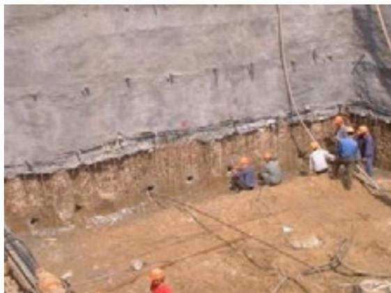
土钉墙的基本形式是在基坑原位土体中置入钢筋(或钢管), 以较密土钉锚固体与土体坡面上的喷射钢筋混凝土面层结合, 形成土钉支护挡土墙。通过土钉墙的土钉、土体和护面共同工作, 抵抗水土压力及地面荷载, 实现稳定的边坡, 是具有自稳能力的基坑挡土墙。当其与隔水帷幕、预应力锚杆及微型桩等构件结合起来后, 组成复合土钉墙。土钉墙、复合土钉墙是基坑支护结构中最经济、施工方便、快速、工期较短, 不需大型施工设备的基坑支护主要形式之一。
