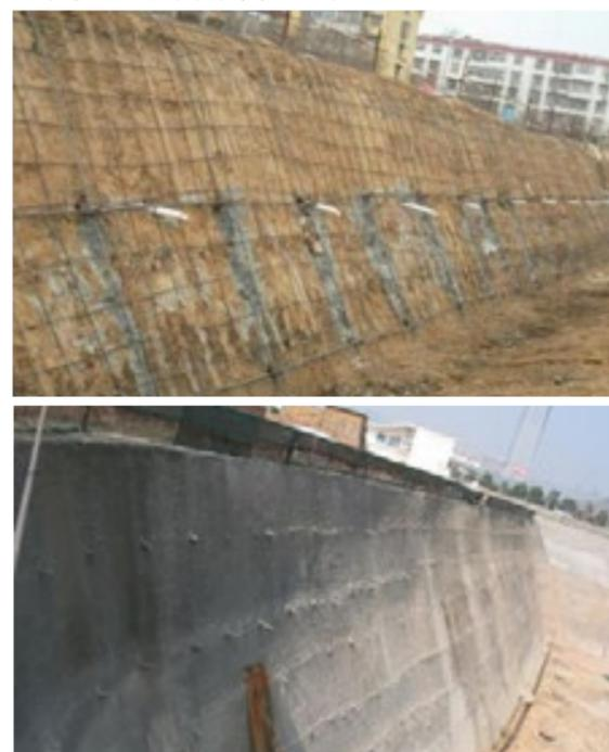
②土钉墙本身变形较小, 对相邻建筑影响较小; 且具有良好的延性, 破坏前有一土体开裂的变形过程, 给人以防范措施的时间;
