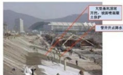
基坑放坡大开挖是一种最简单的基坑施工方法, 优点是施工速度快, 相对措施费用不高; 缺点是周边场地要空旷, 开挖和回填土方量大。放坡坡度的大小与地区土质有关。
