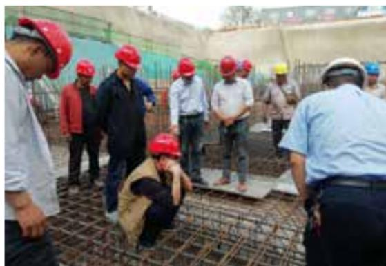
5月14日下午，建筑公司承建的宸流村城中村改造项目地块九工程组成了甲方、监理、质监站、设计单位、施工单位，五方相关人员对1#楼基础钢筋进行隐蔽验收，关键部位重点检查，对整个施工过程的检查记录，五方单位验收一致认为良好，该工程质量达到预定目标，资料齐全且与工程进度同步，一致同意验收合格。钢筋隐蔽工程验收通过后，2台泵车连续浇筑砼，出门车辆百分百冲洗，不带一点泥土上路，现场施工作业洒水除尘使灰尘公害降至最小程度，符合环保部门的规定。
