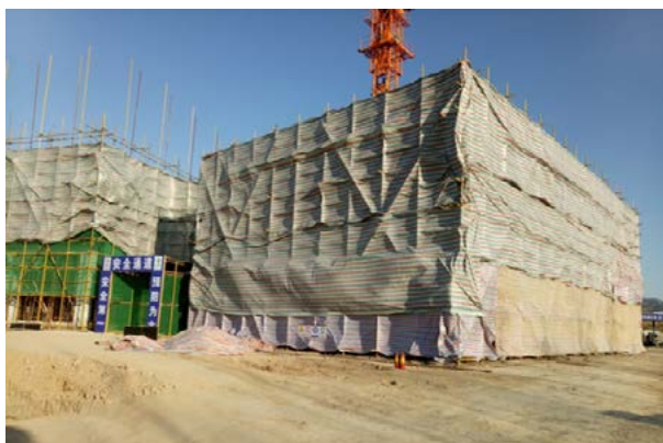
综合楼主体结构施工
