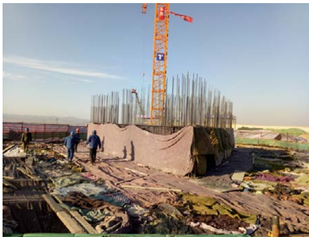
烟囱基础混凝土浇筑完成后采取保温措施
