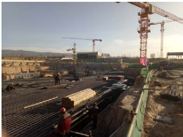
焚烧发电工房基础钢筋绑扎
